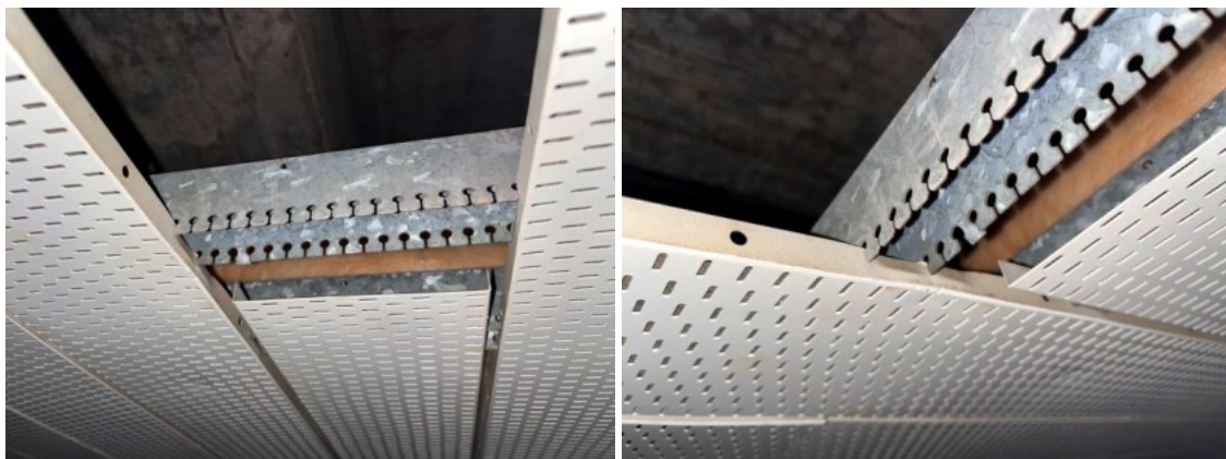
Obr. č. 3 – Uchycení lamel podhledu
